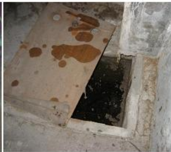
地下室污水池
