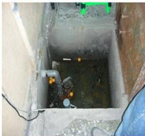
地下室集水槽
