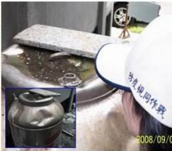
儲水桶鐵蓋凹陷處
