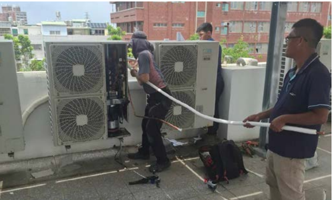
▲更換冷氣銅管，提升機器效率
