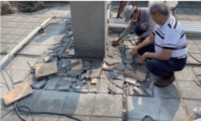
▲宿舍屋頂防漏工程，提高住宿品質
