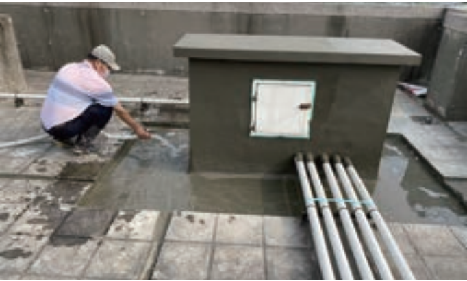
▲宿舍屋頂防漏工程
